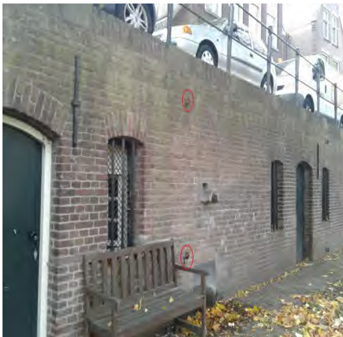
Figuur 4: Voorbeeldfoto positie prisma's (rood omcirkeld)
